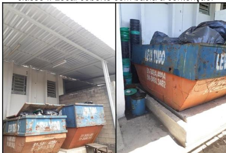
Figura 8 - Área reservada para armazenamento temporário dos resíduos sólidos classe I. Local coberto com bacia a contenção.
