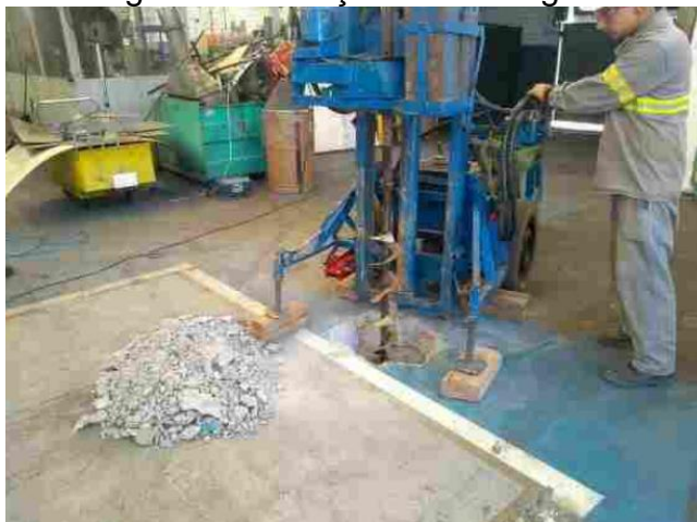
Figura 1 - Serviços de sondagem.
