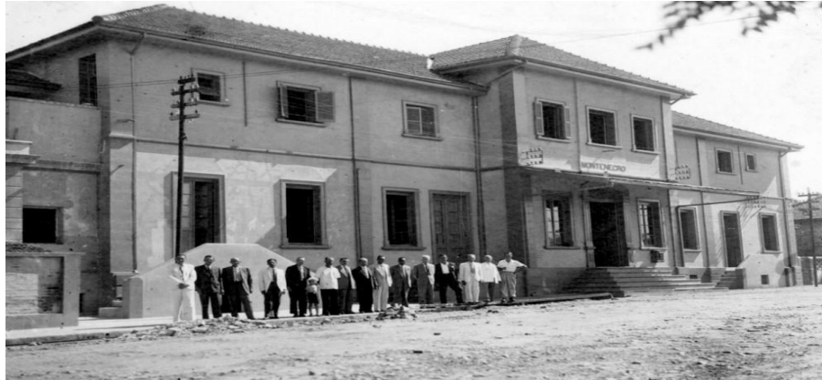
Figura 3: Na década de 40 o prédio ganha um segundo pavimento
