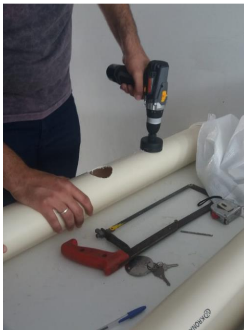
Figura 5 - Broca tipo "copo" para a confecção de orifícios circulares nos canos de PVC
