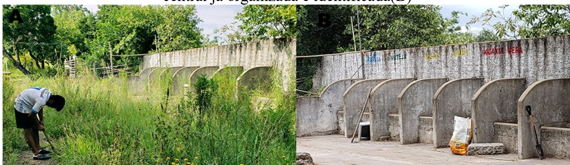
Figura 5 – Início da limpeza do local para construção da central de triagem (A) e central já organizada e identificada(B)
