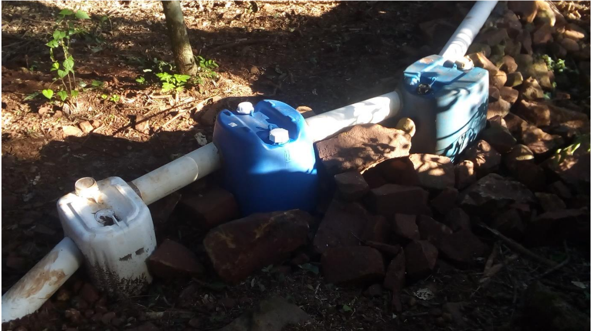
Figura 2 - Fossa séptica com materiais alternativos implantada na propriedade
