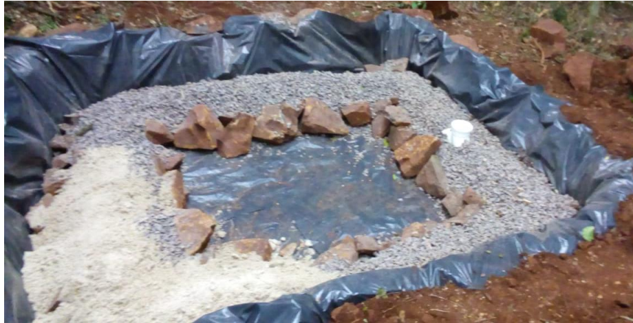
Figura 5 - Colocação das pedras e britas.
