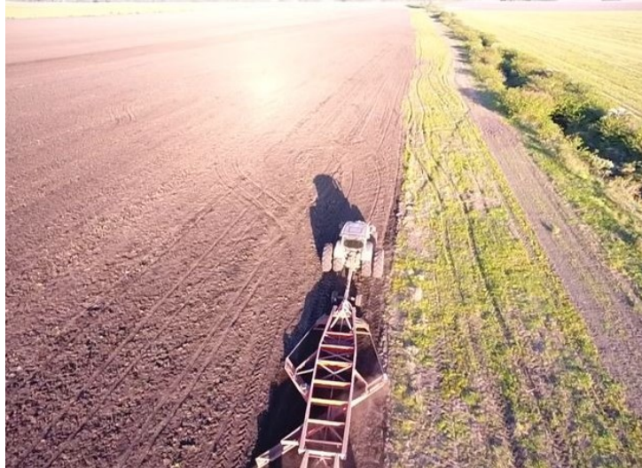
Figura 9 - Imagem das máquinas compactando o solo.
