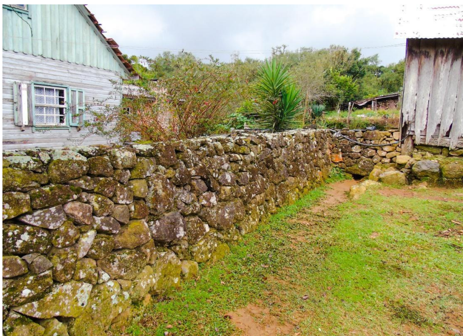
Figura 11 – Taipa construída para proteger a casa de moradia
