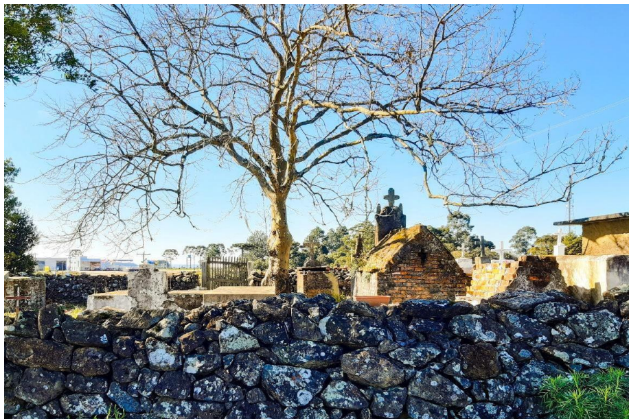
Figura 10 – Taipa construída ao redor de um cemitério comunitário
