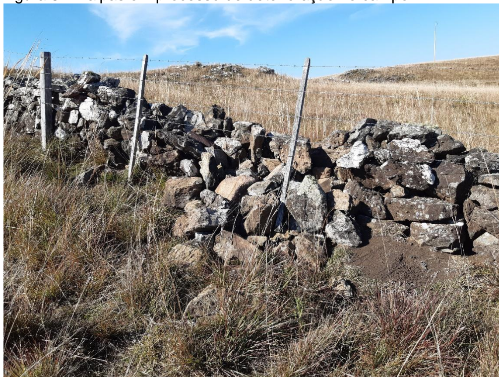
Figura 8 – Taipas em processo de deterioração no campo
