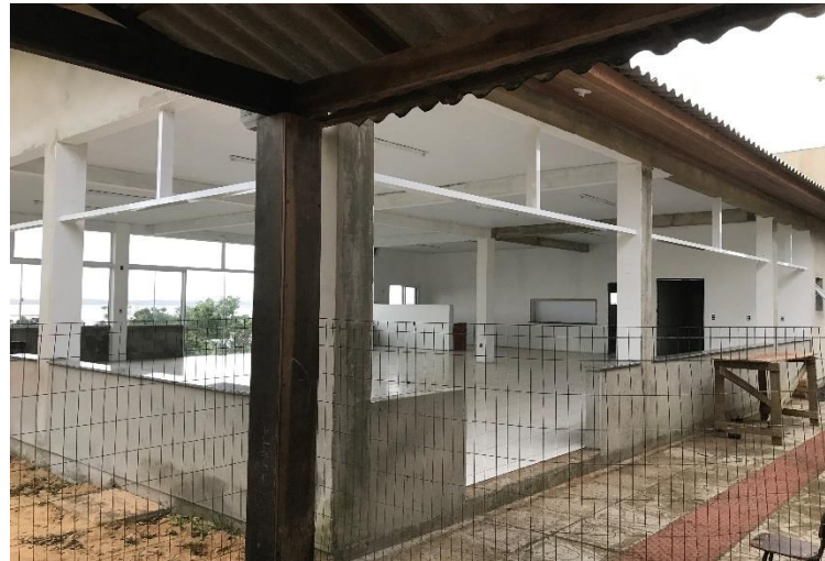
Figura 7 - Foto do refeitório em fase final de construção.
