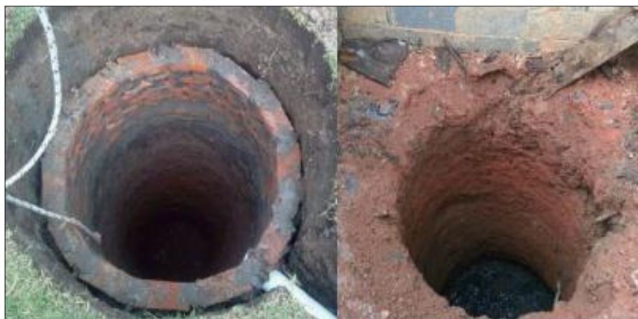
Figura 4 – Fotografia de uma construção de fossa rudimentar
