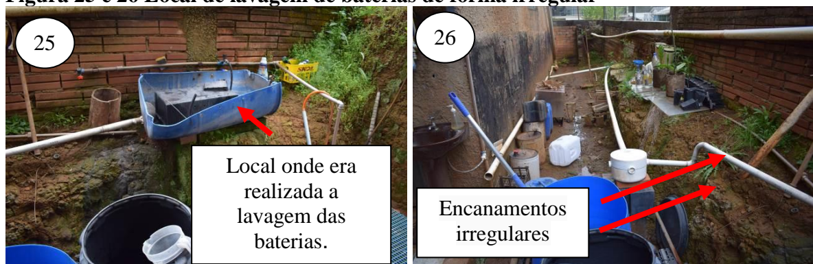
Figura 25 e 26 Local de lavagem de baterias de forma irregular
