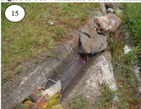
Figura 15 e 16 Vazamento de óleo de caminhão pela canaleta da pista
