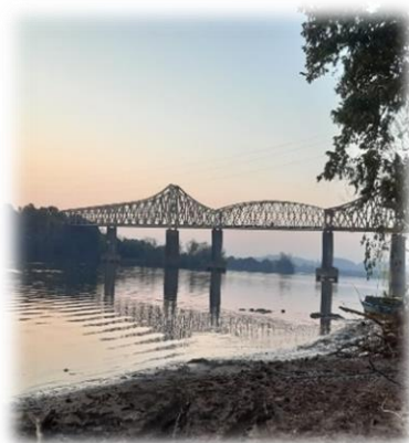
Imagem 23 - Ponte do Barreto
