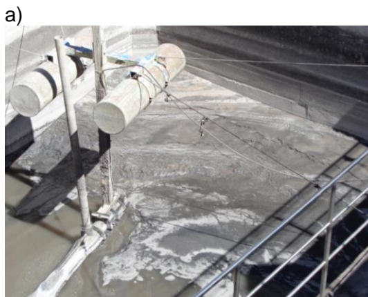
Figura 2 – Imagens de alguns problemas operacionais observados na empresa: a) Tanque equalização com excesso terra filtrante; b) Lodo flotado no decantador primário; c) Lodo do emulsionado do equalizador; d) Teste de decantação do equalizado.
