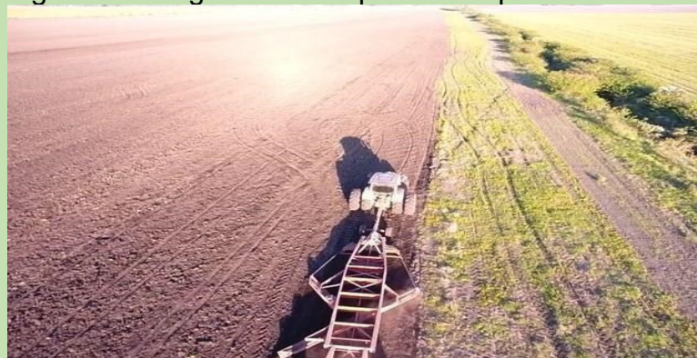
Figura 9 - Imagem das máquinas compactando o solo
