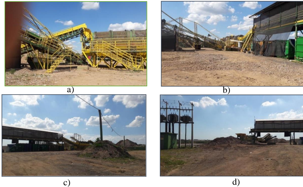
a) Equipamento de separação e trituração de resíduos; b) Galpão de triagem dos resíduos e separação; c) Pátio da usina, no fundo espaço de triagem dos resíduos d) Galpão de triagem e ao fundo os resíduos triturados. Fonte: Autora (2022).
