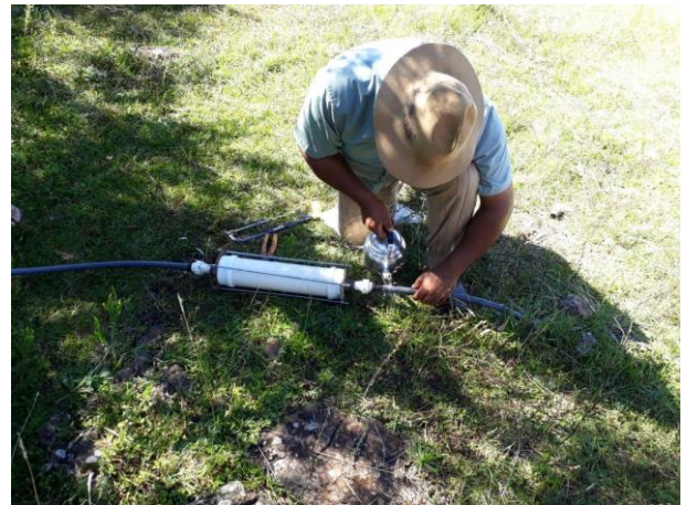
Filtro sendo instalado.
