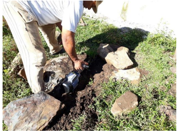
Instalação de motobomba para bombeamento para caixa d'água.
