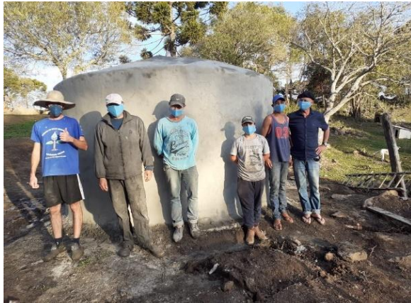
Comunidade atuante na construção coletiva de Cisternas.
