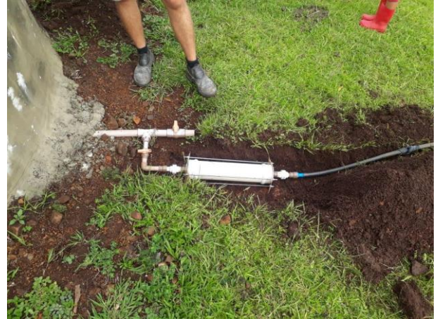
Instalação filtro teste.
