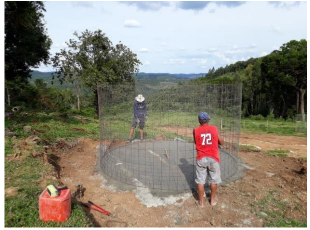
Instalação da parede sobre o piso.
