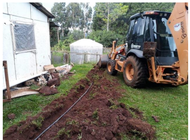
Instalação de mangueiras de distribuição.
