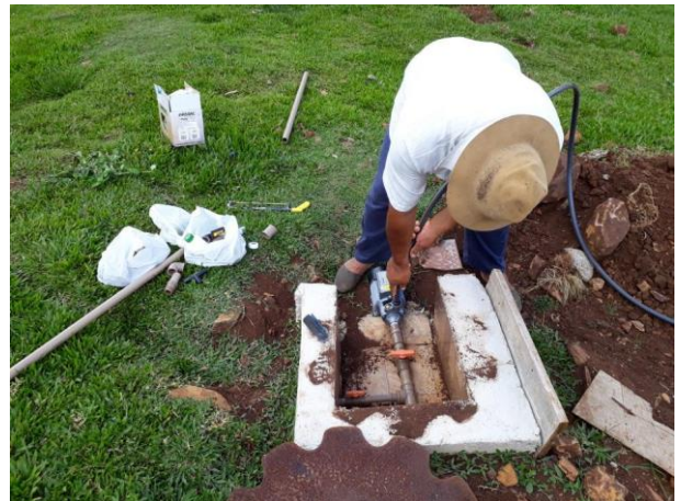
Instalação de motobomba para bombeamento até a cisterna.
