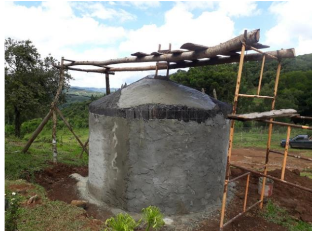
Concretagem da primeira camada do chapéu.
