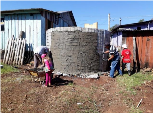
Concretagem da primeira camada da parede.
