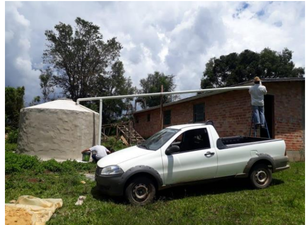
Instalação dos canos.
