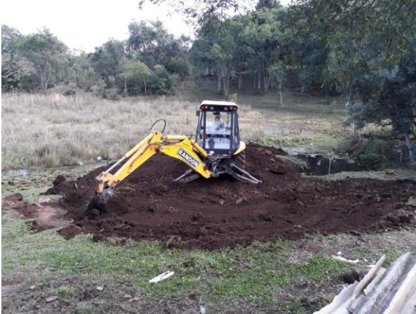
Nivelamento inicial mecanizado da área.
