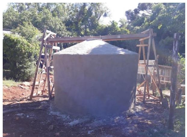
Cisterna com concretagem concluída e polida.
