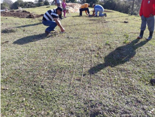
Amarração da parede.
