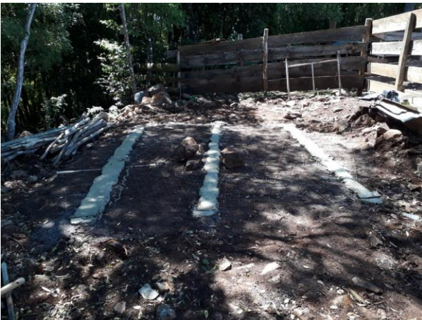
Mestras em nível para concretagem do piso.
