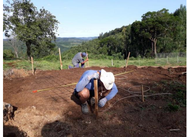
Nivelamento com mangueira de nível.
