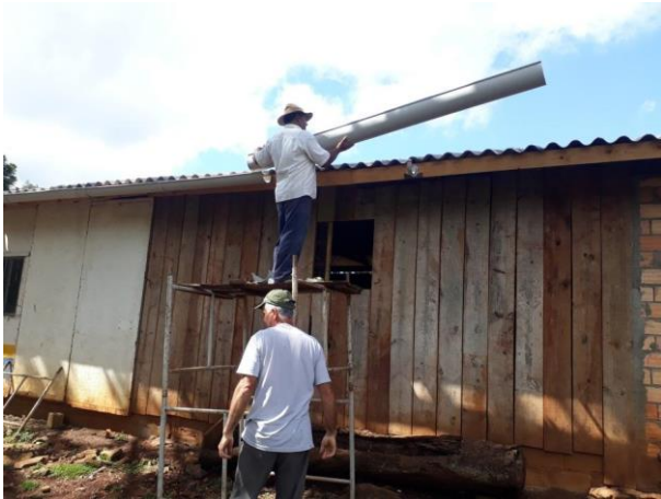
Instalação das calhas.
