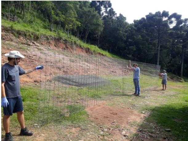
Ferragem da parede pronta para instalação.
