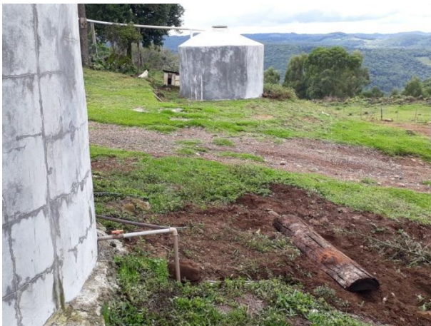
Cisternas interligadas com distribuição por gravidade até a rede.
