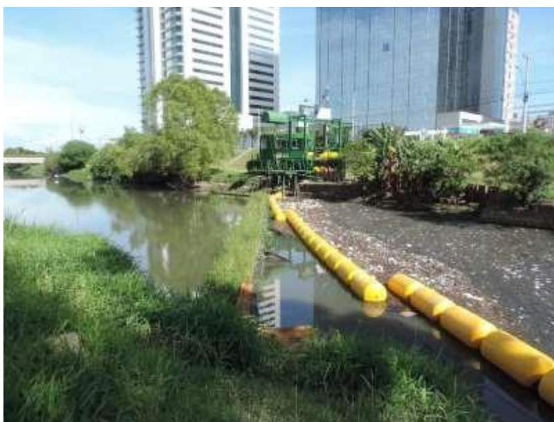
Figura 3 - Modelo de Ecobarreira do arroio Diluvio, em Porto Alegre, RS
