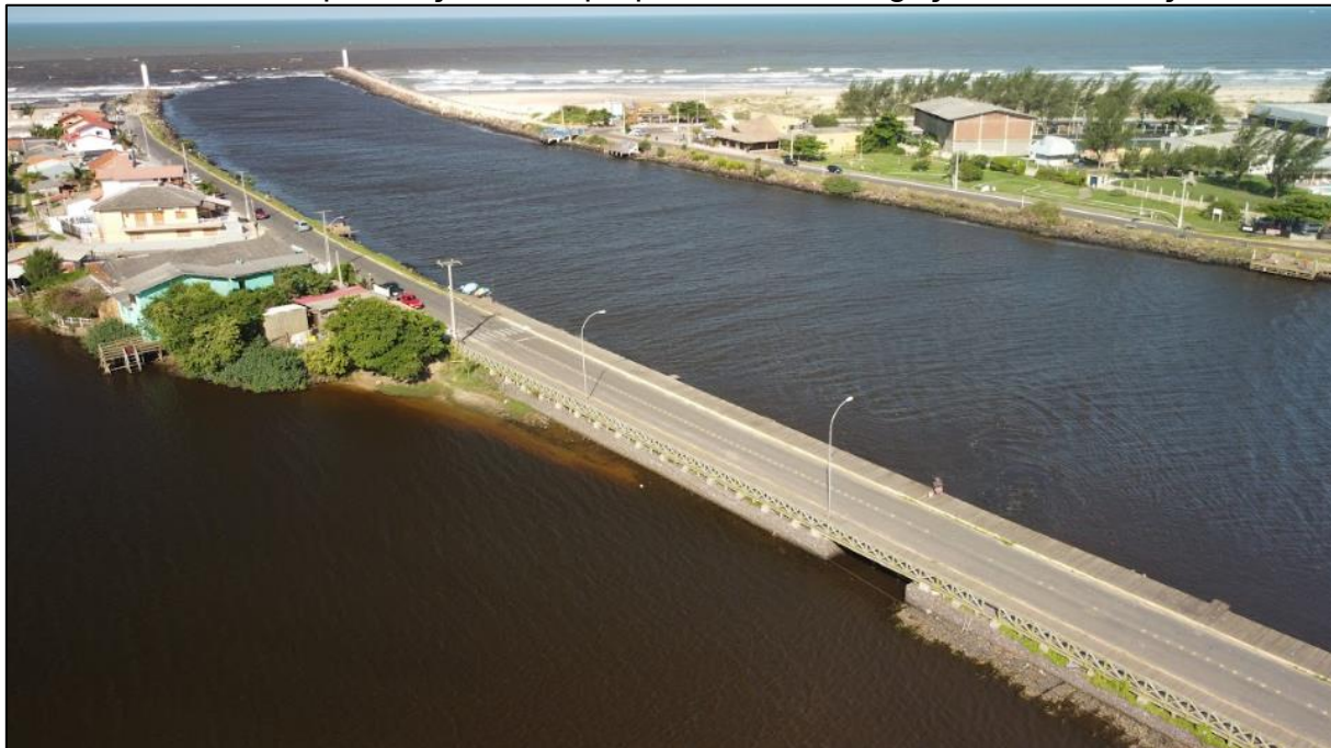
Figura 23 - Foz do Rio Mampituba entre as cidades de Torres/RS e Passo de Torres/SC, com a presença de um pequeno canal de ligação com o “braço morto”
