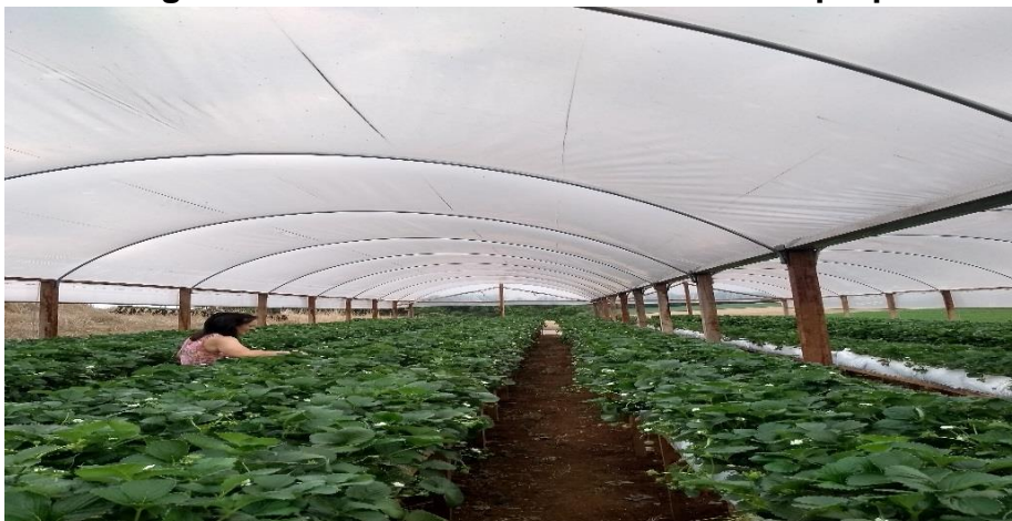
Figura 03 - Infraestrutura das estufas na propriedade.
