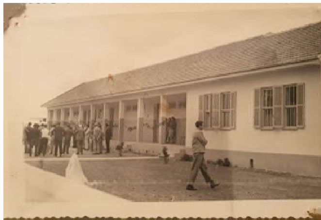
Fotografia 3 - Prédio de alvenaria construído em 1980
