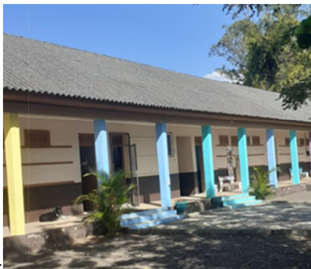
Fotografia 5 - Prédio da escola após reformas (2019)
