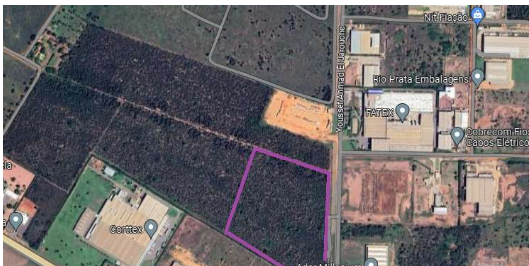
Figura 37 - Área para instalação da planta industrial
