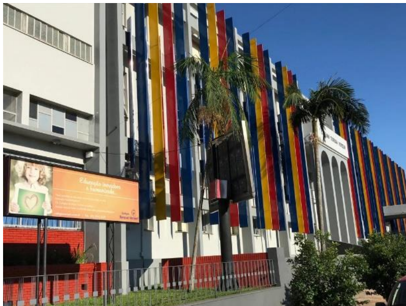
Figura 5 – Fachada Colégio Tereza Verzeri em 2019 após atualização na pintura
