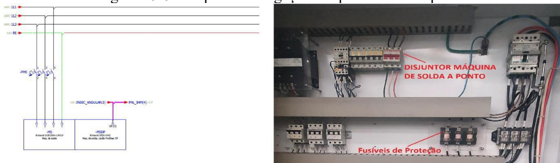
Figura 15.8 - Esquema de ligação máquina de solda ponto
