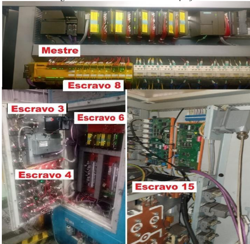
Figura 15.7 - Rede Profibus física do projeto
