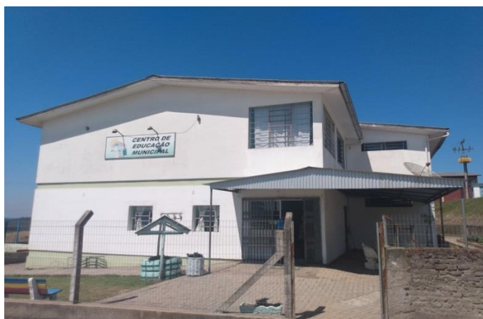
Figura 1 - Vista frontal da estrutura do Centro de Educação Municipal (CEM). Fontoura Xavier/RS. 2019.
