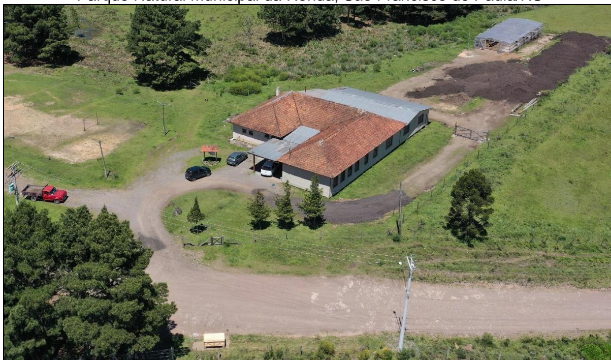
Figura 31 - Vista aérea do Centro Integrado Social (CIS) localizado junto a sede do Parque Natural Municipal da Ronda, São Francisco de Paula/RS
