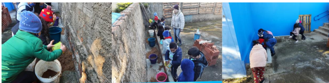
Imagem 13 - Enchimento dos canteiros. Cachoeira do Sul/RS, 2022.
