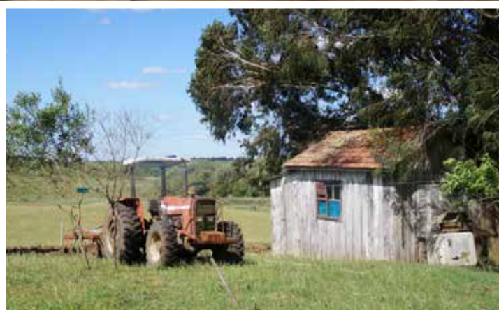
Antigo galpão para fazer queijo. Típica construção das propriedades familiares
