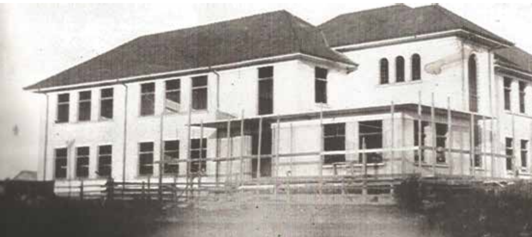
Construção do atual prédio da Escola Antônio Francisco Fonte: Acervo da Escola
