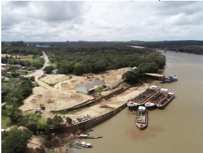
Figura 15 - Terminais hidroviários de minério, município de Rio Pardo, RS
