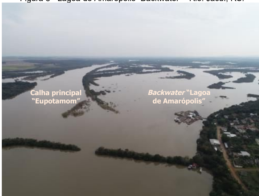
Figura 8 - Lagoa de Amarópolis "Backwater" - Rio. Jacuí, RS.
