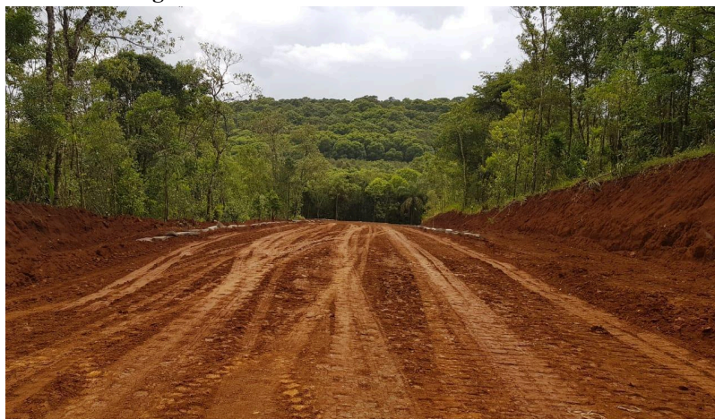
Figura 2: Ruas sendo abertas em um loteamento
