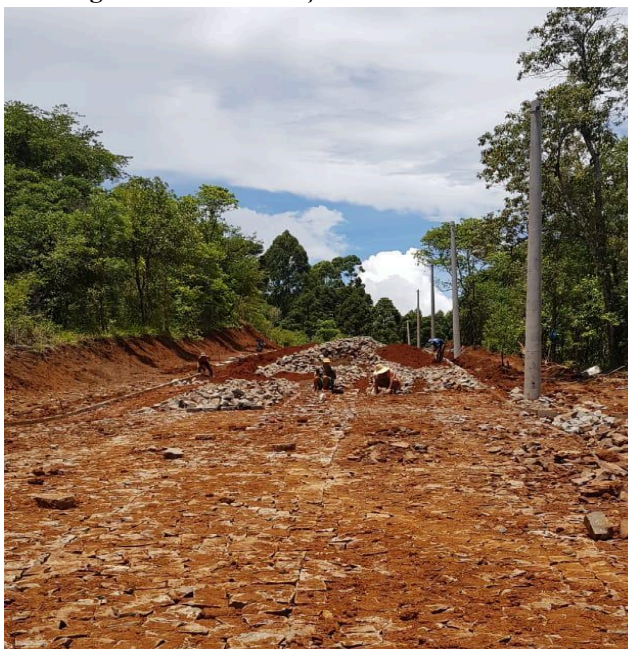
Figura 3: Vista do calçamento sendo executado
